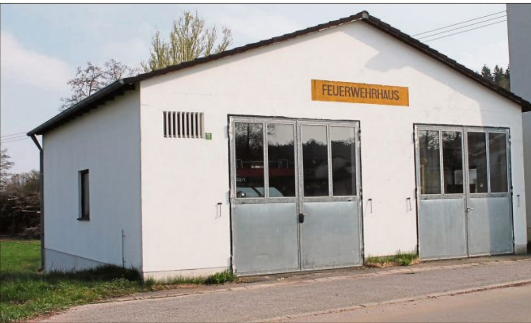
So sah das alte Feuerwehrgerätehaus aus.
